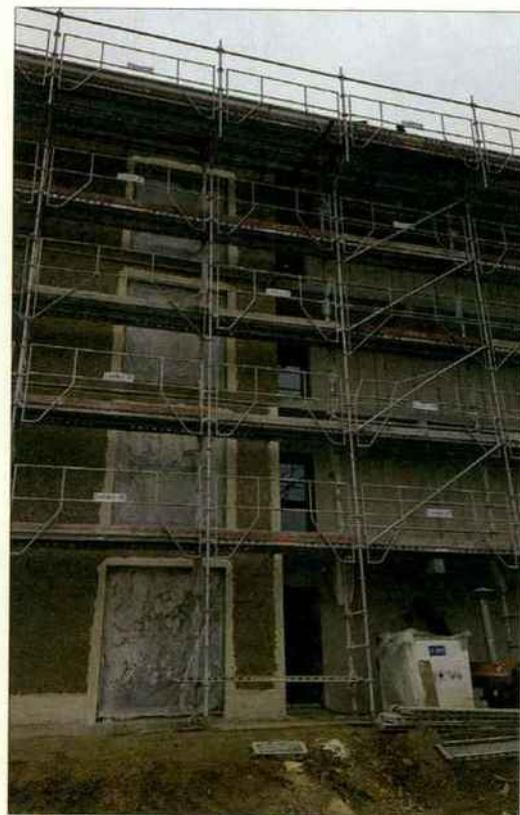
Chantier en cours d'une opération de 45 logements sociaux en ossature béton avec façades en béton de chanvre projeté à Trilport (77), réalisé par l'agence Être et Chêne de l'architecte Philippe Lamarque pour Foyer Rémois.
