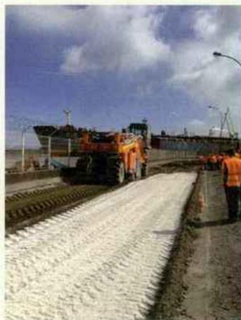
Les sédiments ne rentrant dans les normes de construction, des chantiers tests ont été réalisés sur une route au port de Dunkerque @IMT Lille Douai
