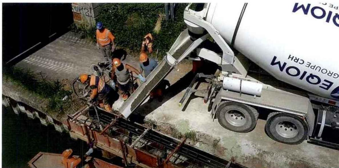
Du béton à base de sédiments a été livré par l'entreprise Eqiom lors du chantier de réalisation de poutre de couronnement de palplanches en vue de la réfection d'un quai de Douai en partenariat avec Voies navigables de France @IMT Lille Douai
