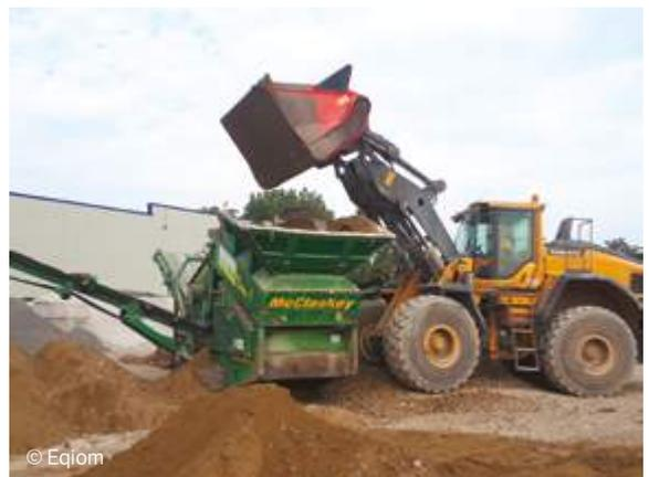
Criblage de sédiments sur le site d'Eqiom pour la fabrication d'un ciment
