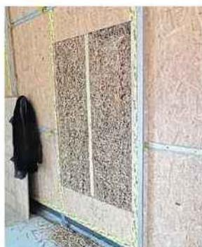
La paille d'un agriculteur local a été compressée dans les parois pour servir d'isolant.
