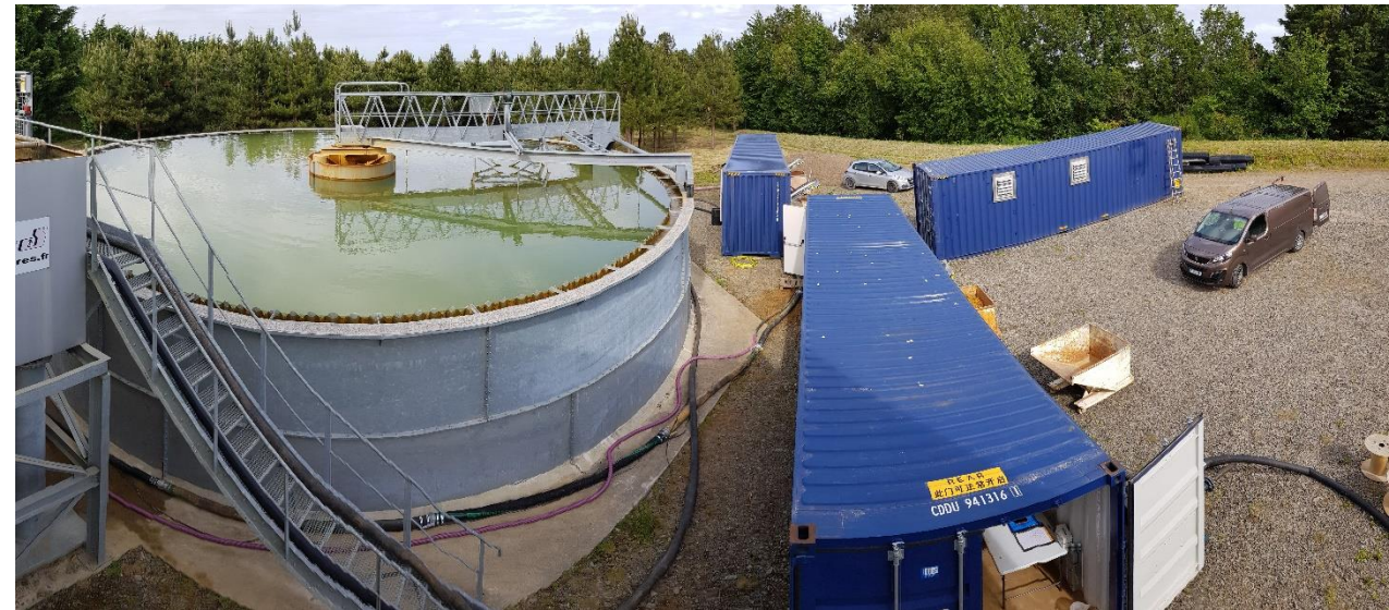
La Sablière des Landes quarry
