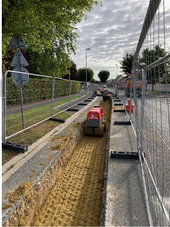
▲ Déploiement du réseau dans la rue Pasteur prolongée
