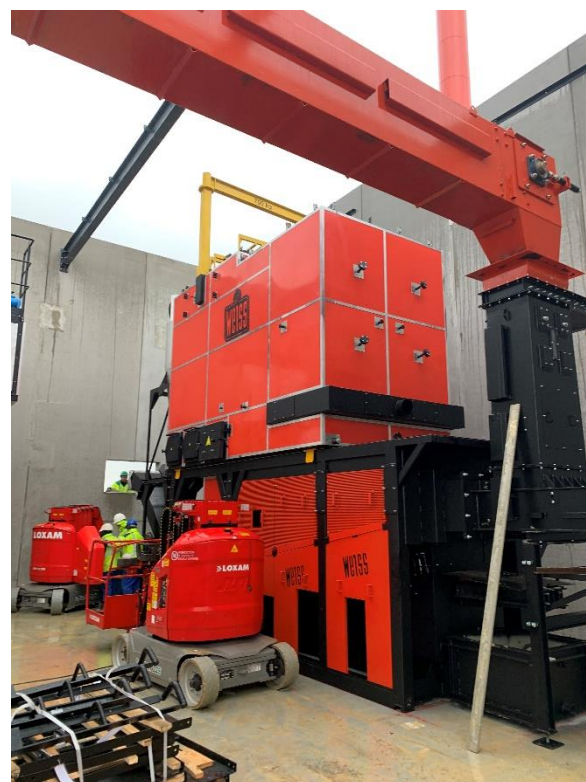
Assemblage de la nouvelle Chaudière Biomasse
