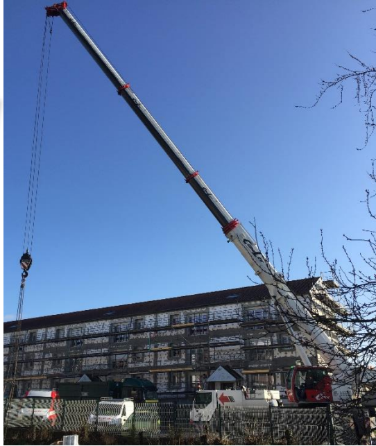
Réhabilitation thermique du bâtiment sis rue Amand de Vienne
