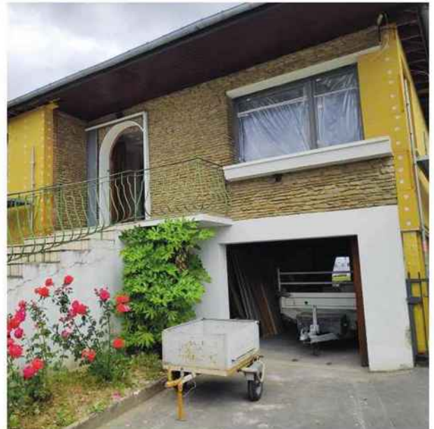
Le choix a été fait d'isoler la maison par l'extérieur et les combles avec l'utilisation de matériaux biosourcés.
