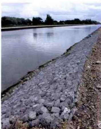
Matelas de gabions incorporant des sédiments
