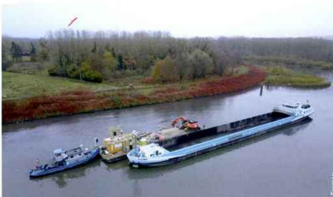
Opération de dragage pour VNF Nord-Pas-de-Calais
