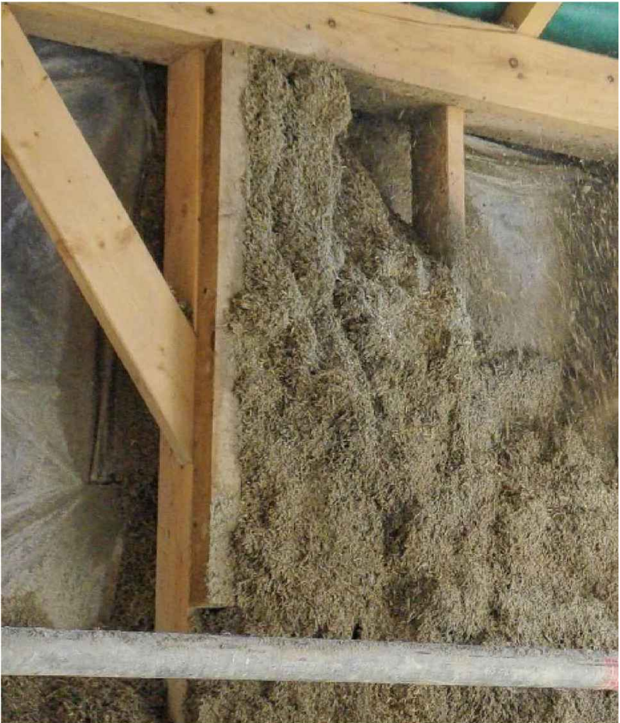
La filière chanvre dans l'isolation existe, mais elle est naissante et encore fragile. Ici un ouvrier utilise du béton de chanvre pour isoler un bâtiment. Archives L'Ardennais
