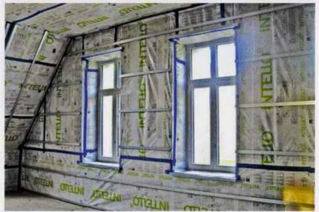
Grâce à la membrane hygrovariable de pro clima, le bâtiment dispose d'un potentiel de séchage permettant à la teneur en eau de la paroi de s'équilibrer sur l'année (été - hiver), afin d'éviter qu'elle ne se charge en humidité sans pouvoir sécher, et ce, afin de prévenir tout risque de moisissures et de dégradation du bâti.
