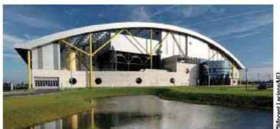
Le Centre de valorisation énergétique (CVE) à Halluin.
