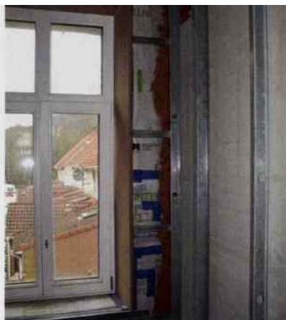
Les menuiseries en mélèze certifié PEFC lamellé-collé en 4 plis portent du triple vitrage.
