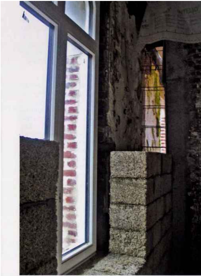
On voit ici le doublage du mur en béton de chanvre. L'espace entre le mur porteur et l'ensemble maçonné est comblé par de la chènevotte en vrac pour couper les ponts thermiques.
