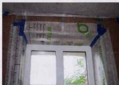
Ebrasement des ouvertures pour une isolation et une étanchéité à l'air continues.
