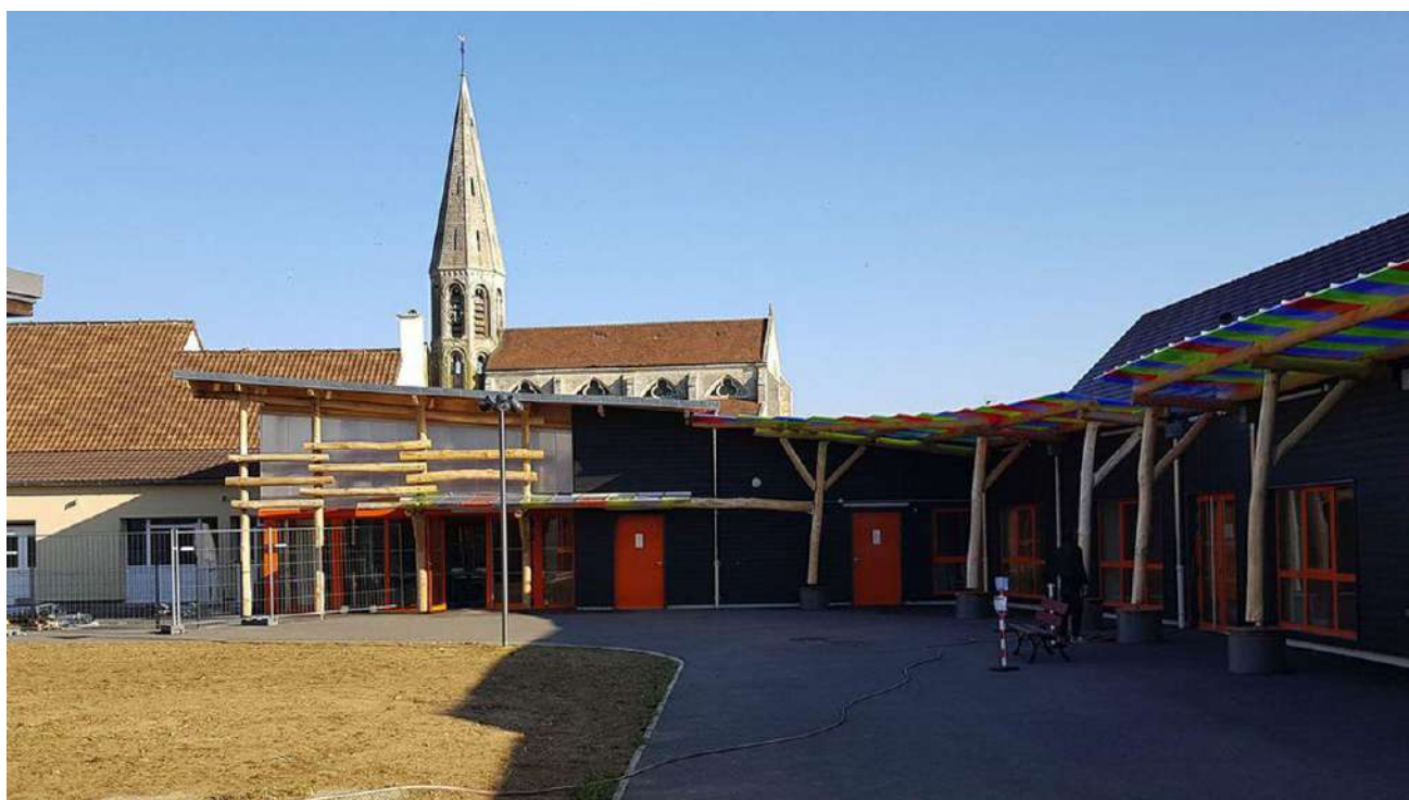
L'école de Cambronne-lès-Clermont est réalisée en ossature bois et isolation paille. (DR)
