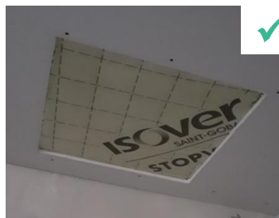
A l'emplacement de la trappe d'accès aux combles : faire revenir la membrane sur le cadre et s'assurer de l'efficacité du joint entre le cadre et l'ouvrant (non achevé sur la photo)
