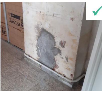
Reboucher les pots à suie avant de poser le doublage intérieur
