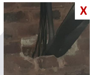
Colmater les pénétrations de réseaux
