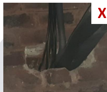
Colmater les pénétrations de réseaux
