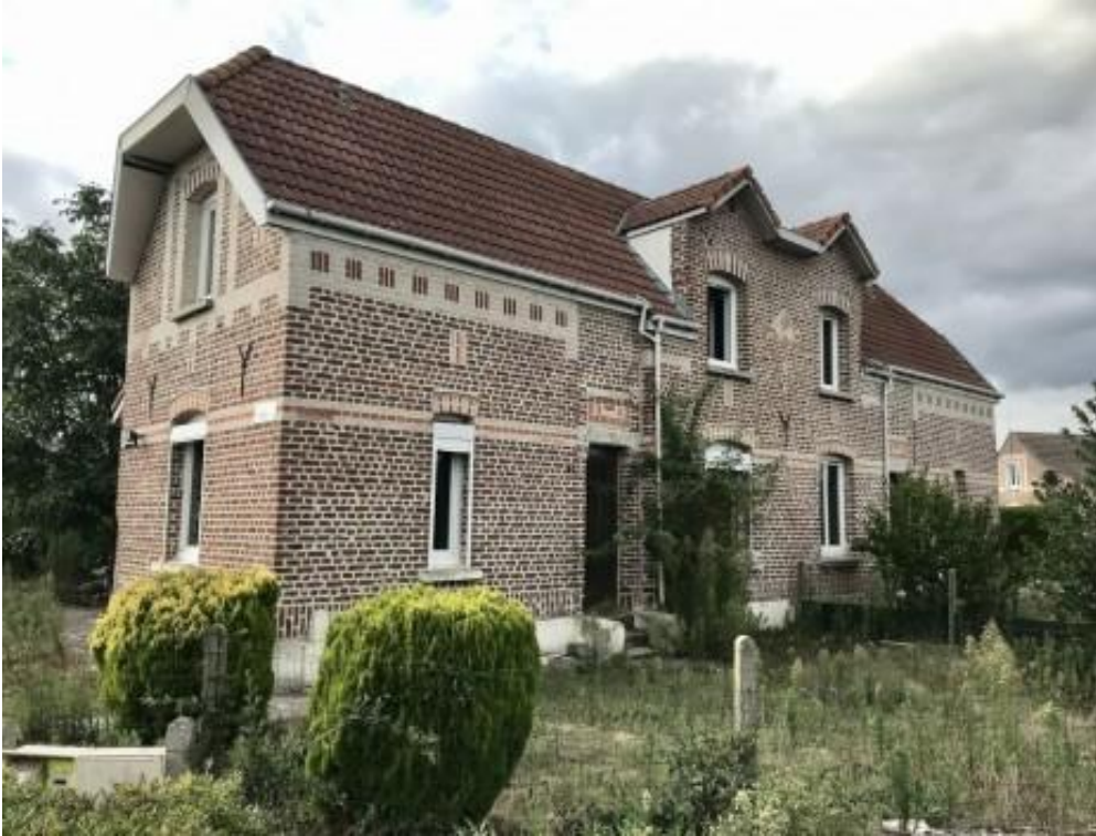
Une maison de la cité Barrois, à Pecquencourt (Nord). © L-A Fournier
