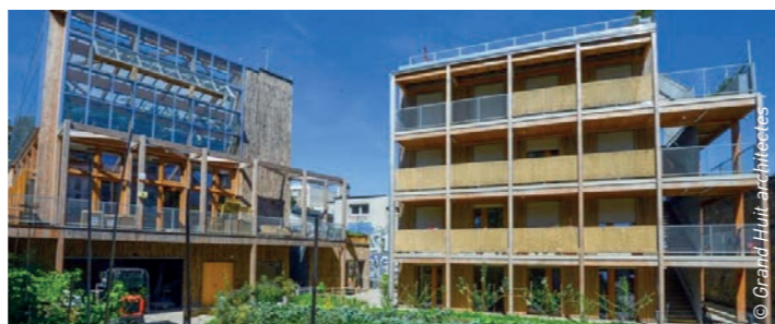
«Ferme du Rail», Grand 8 architectes. Ferme de polyculture et d'insertion à Paris [75] lauréate de «Réinventer Paris». Programme mixte (logement, restaurant, agriculture urbaine...). Low Tech, construction bois paille de haute performance. https://www.fermedurail.org/
