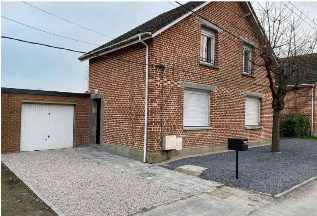
Au 45, rue de Vimy, le logement sera isolé avec du lin.
