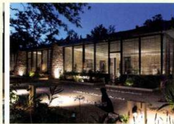
Deux projets primés en 2022 aux Trophées de la Construction Passive : A gauche, Les Grands Moulins de Paris à Marquette-lez-Lille (MAES Architectes Urbanistes). Ci-contre, rénovation au standard neuf d'une école de Jean Prouvé. Rolf Matz Architecture (voir HN n°76).
