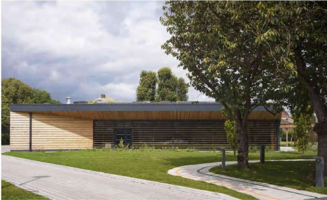
L'Abeille gourmande, restaurant scolaire passif à Loos, Delsinne Architecte © Julien Lanoo Photographe
