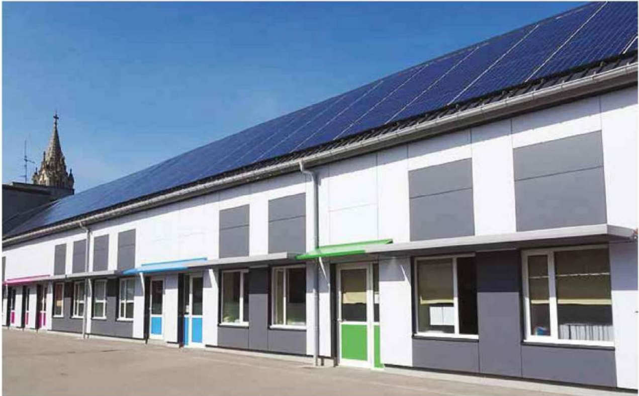
I Centrale citoyenne sur l'école d'Erquihem-Lys.
