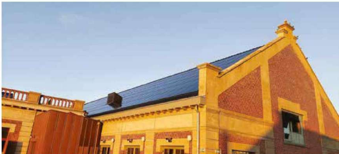
| Toiture solaire du 11/19 portée par la Communauté d'agglomération Lens Liévin.
