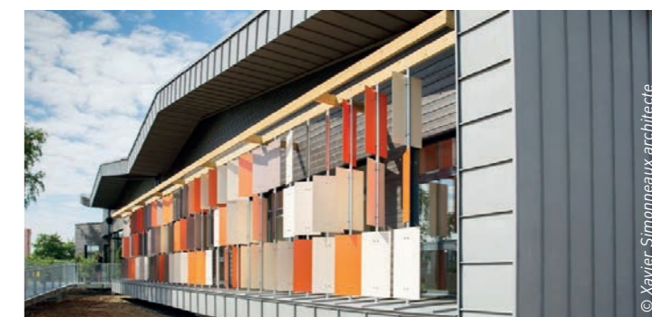
Bureaux de la Fédération Française du Bâtiment (FFB). Construction bois et paille à haut niveau de performance énergétique à Compiègne (60). Xavier Simonneaux architecte
