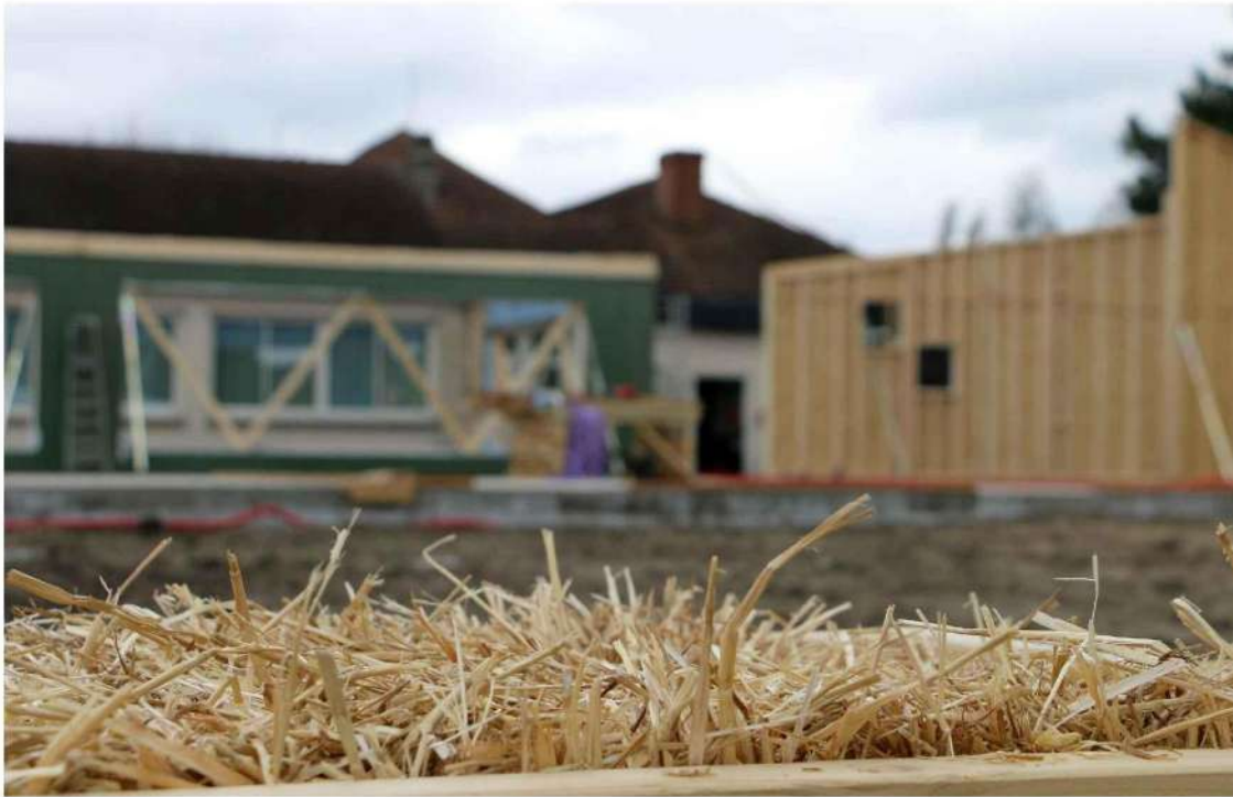
À Pont-Sainte-Maxence, la première des 4 900 bottes de paille qui vont garnir les cloisons de l'école primaire Adrien-Bonnel vient d'être posée.
