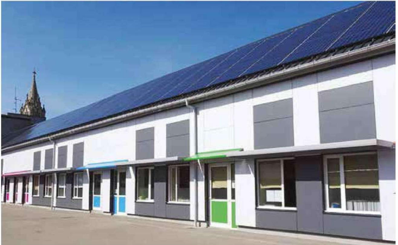
I Centrale citoyenne sur l'école d'Erquihem-Lys.
