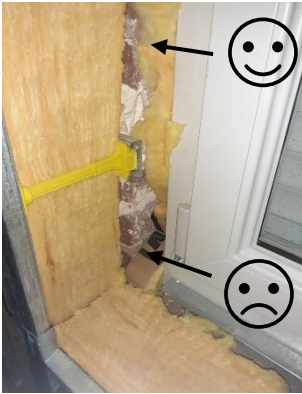
Isoler le fond de feuillure
