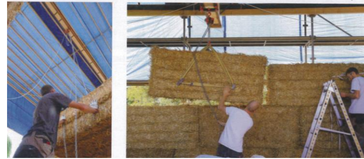
Levage des bottes porteuses Source : La maison Heiko, Ehrlich et Mosiniak
