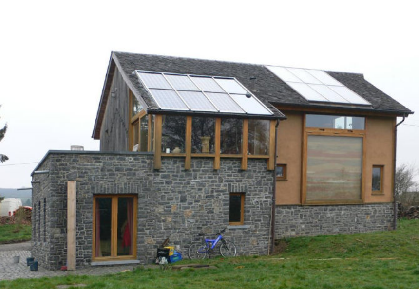
Maison solaire à Bouillon, Belgique
