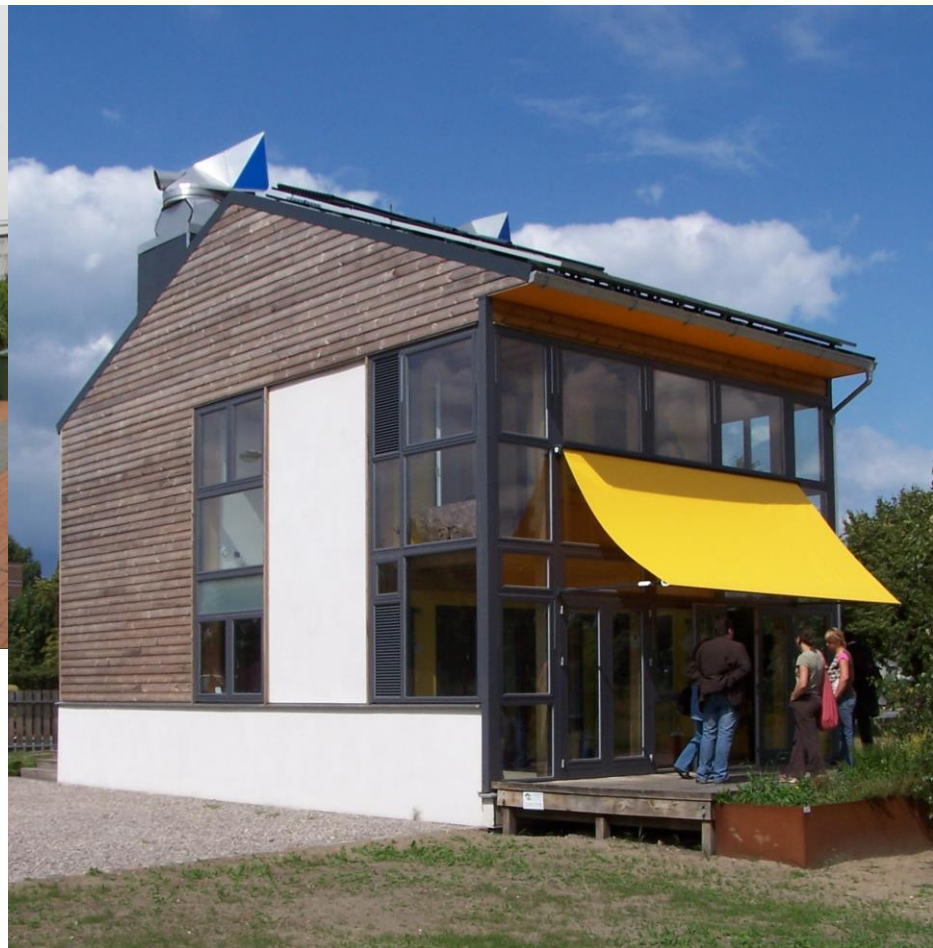
Serre chauffée : Ruralzed, maison de Grande-Synthe, ZEDfactory, 2010
