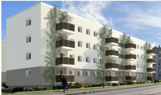
Résidence Logissia Flers - 112 balcons (Pose juillet 2023)
