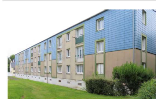
Résidence Les Gallières Blois 104 balcons (pose décembre 2023)
