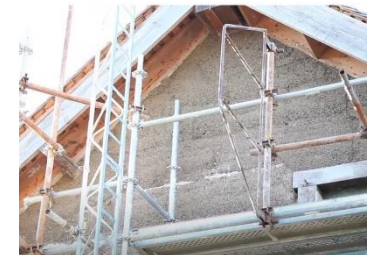
Maison en banché
