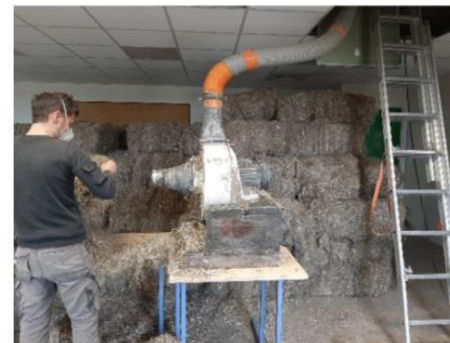
Figure 5 : Soufflage du chanvre dans les combles depuis le R+1
