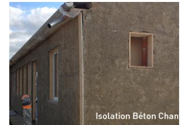
Isolation Béton Chan Ecole à Agen en projection
