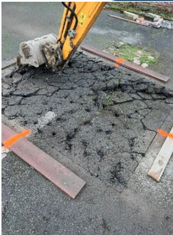
Réalisation des fosses
