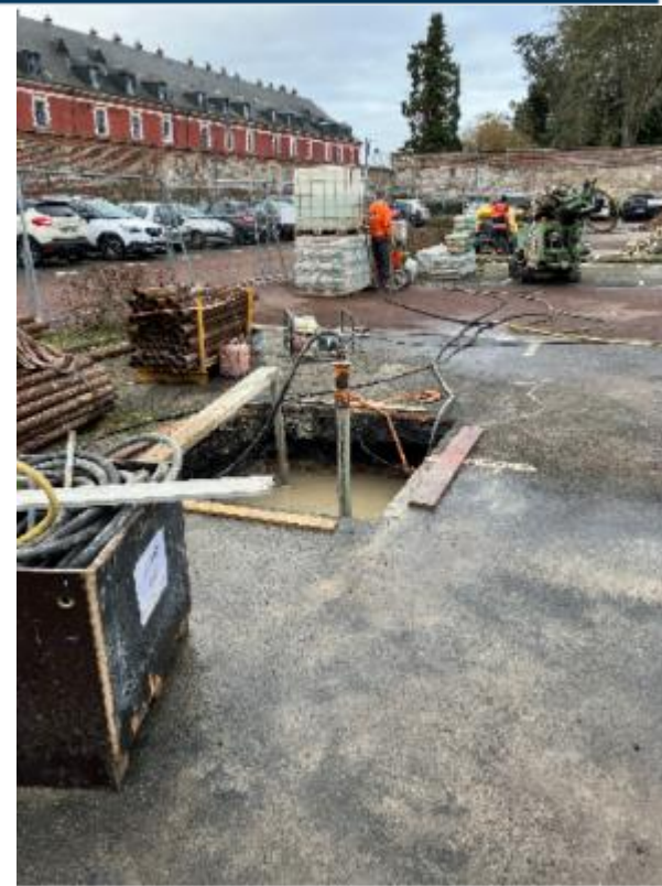
Injection du béton
