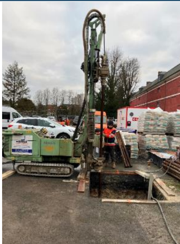
Forage des Micropieux
