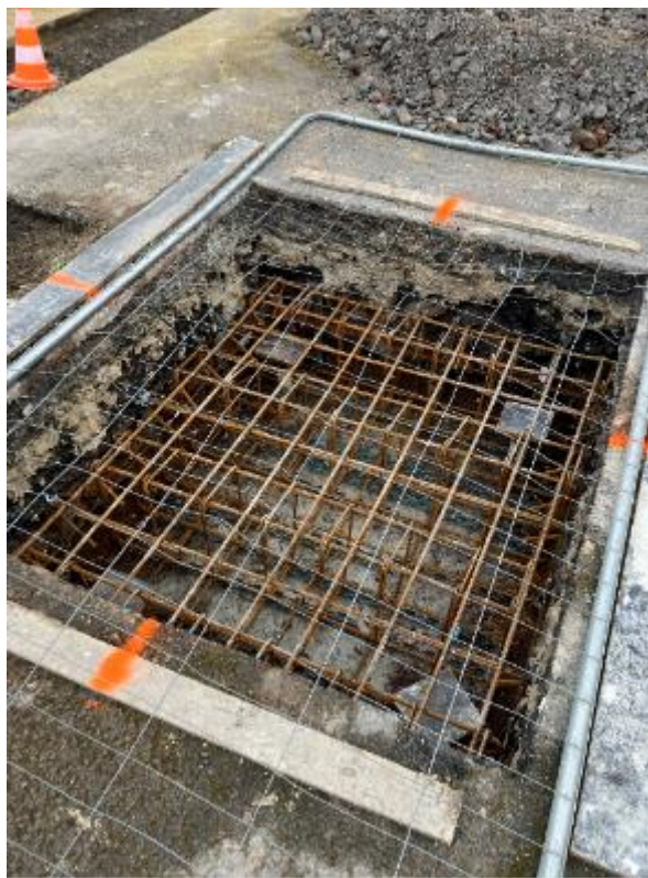
Pose des fers à béton
