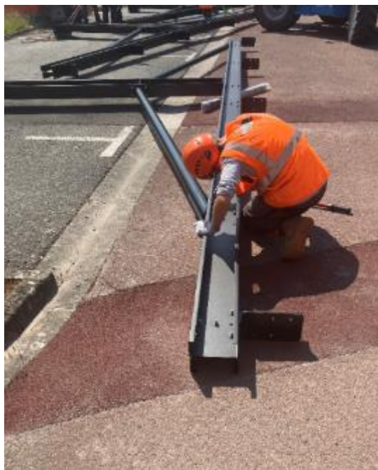
Assemblage des structures
