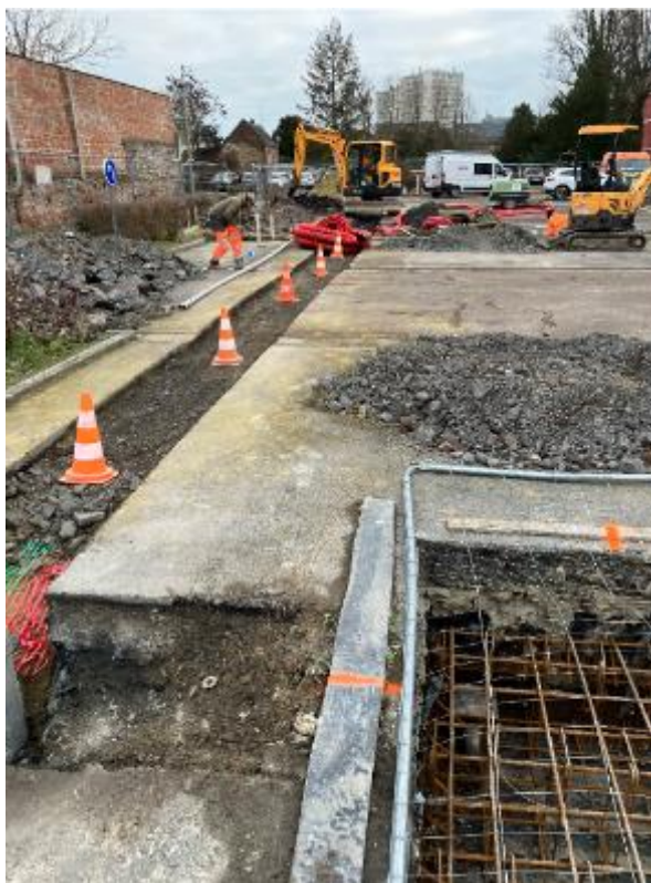
Réalisation des tranchées
