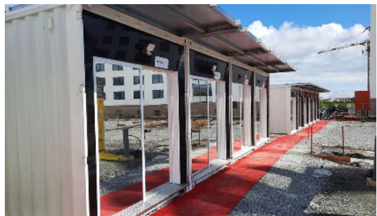
BASES VIE DE CHANTIER
