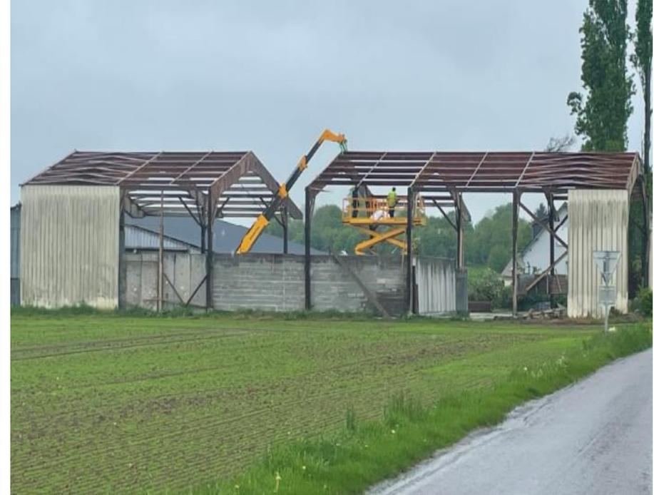
Récupération de l'ossature « Lamellé-collé » suite à une déconstruction sélective et soignée d'un hangar agricole
