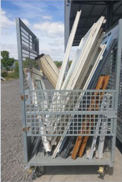
Démantèlement des menuiseries vitrées en fin de vie
