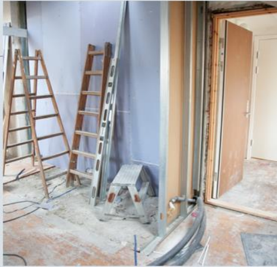
Dépose préservante/ déconstruction sélective
