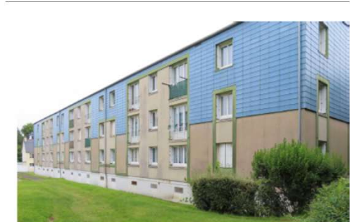
Résidence Les Gallières Blois 104 balcons (pose décembre 2023)
