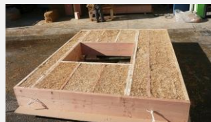
Remplissage ossature bois 31.2, 31.1 préfa ou non
