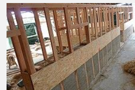
Enduits coulés ossature tunnel
