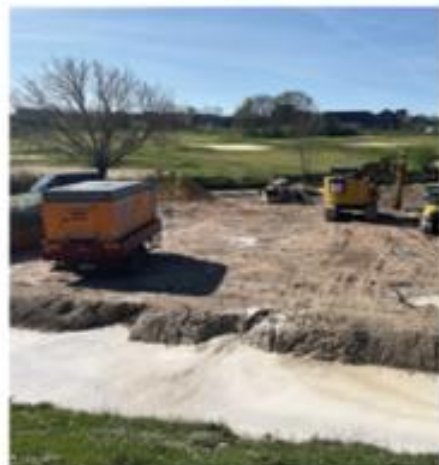
Pose des premières sondes
