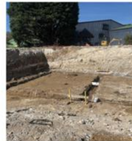
Fondations du local technique
