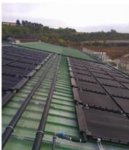
Pose des capteurs et raccordement
