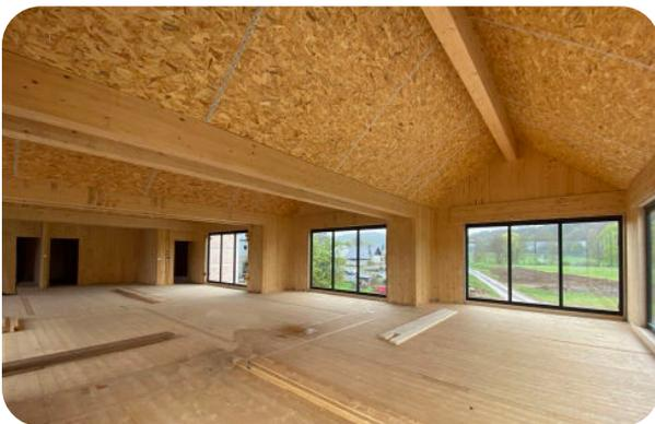
En sous-toiture, des caissons préfabriqués accueillent l'isolation assurée par des **matériaux biosourcés** : matelas de fibres d'herbe de chez Gramitherm et laine de bois.
