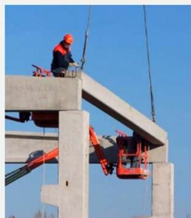
Structure béton préfabriqué
