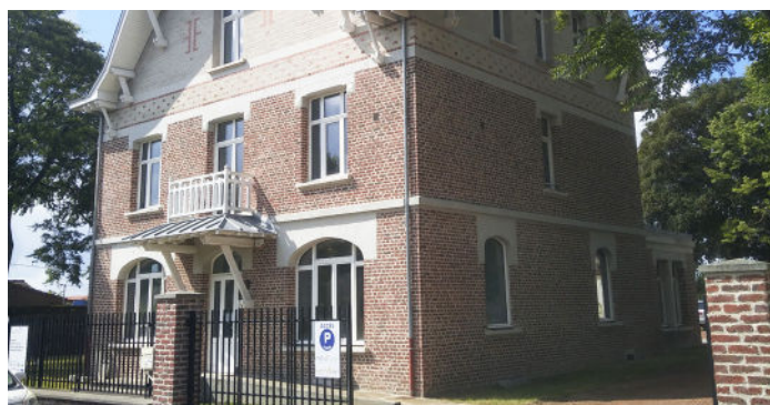
La maison de l'ingénieur - Réhafutur 1
