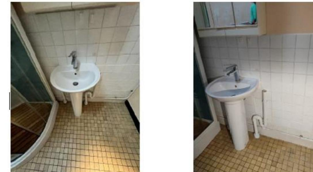
Précaution de dépose : coupez l'arrivée d'eau – désolidarisez le lavabo du système d'arrivée et d'évacuation d'eau > démontez le lavabo > récupérez le lavabo
