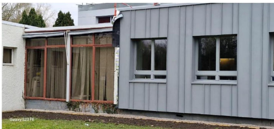
Façade préfabriquée en remplacement des existantes vétustes. (Image MOA APRADIS)
