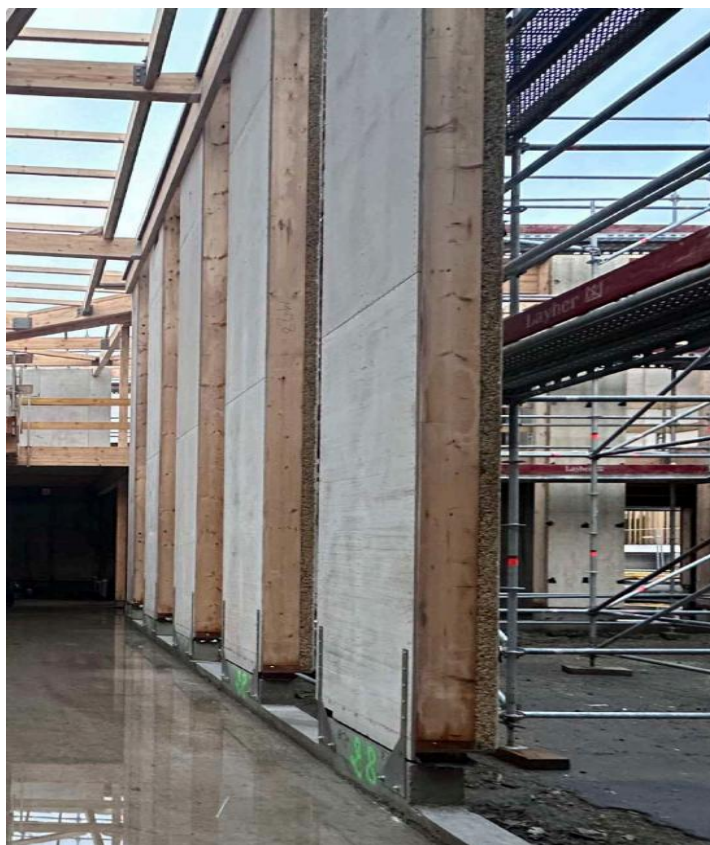
MOB préfa, béton de chanvre. Wall-up, montage Ambois, Credit: Laps architecture, Chantier mairie de Rousies, Ville de Rousies
