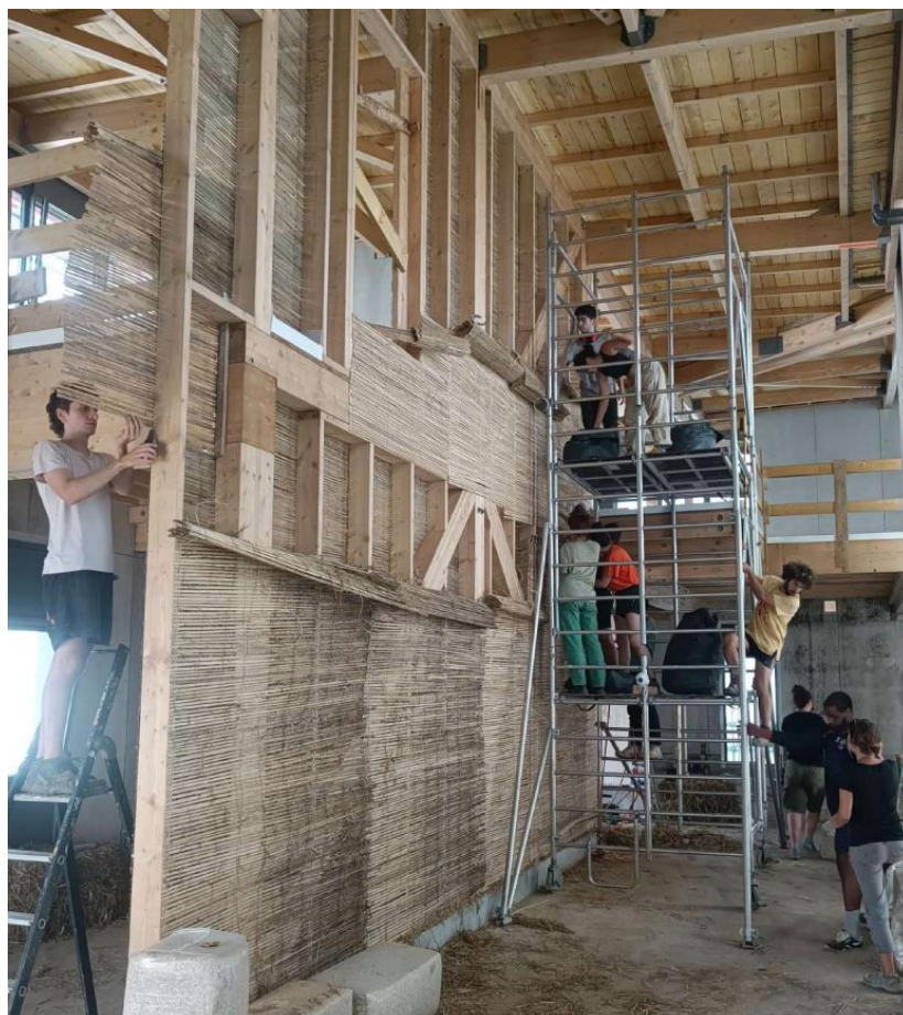
Pose des cannisses sur mur ossature bois et remplissage terre-paille chanvre. Laps architecture, Chantier mairie de Rousies, Ville de Rousies
