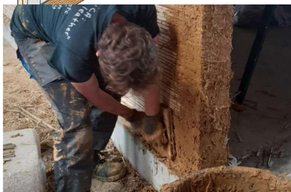
Enduit Terre chanvre, Laps architecture, Chantier mairie de Rousies, Ville de Rousies
