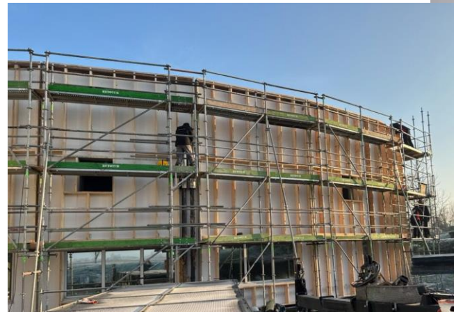
Pose des ossatures bois en facette, Entreprise : Bati Bois Concept Nord
