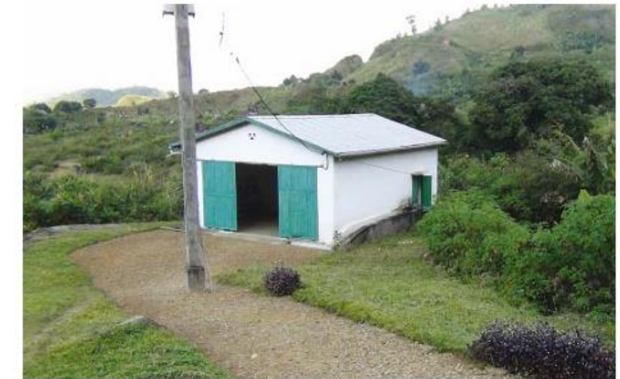
Bâtiment de la centrale de Tolongoina
