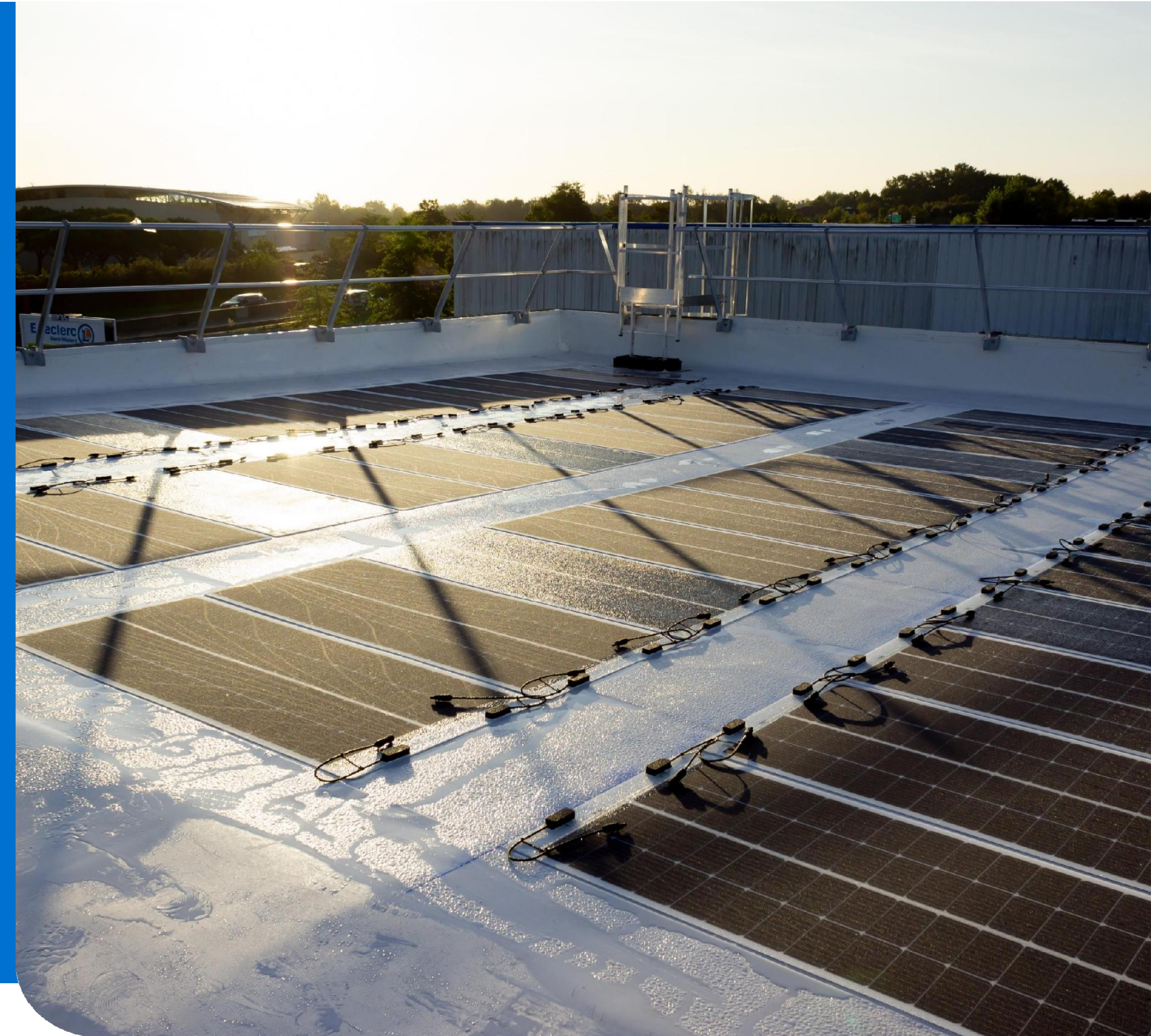
Chantier SIEDS Poitiers - Crédit photo : ATYPIX - SOPREMA Entreprises
