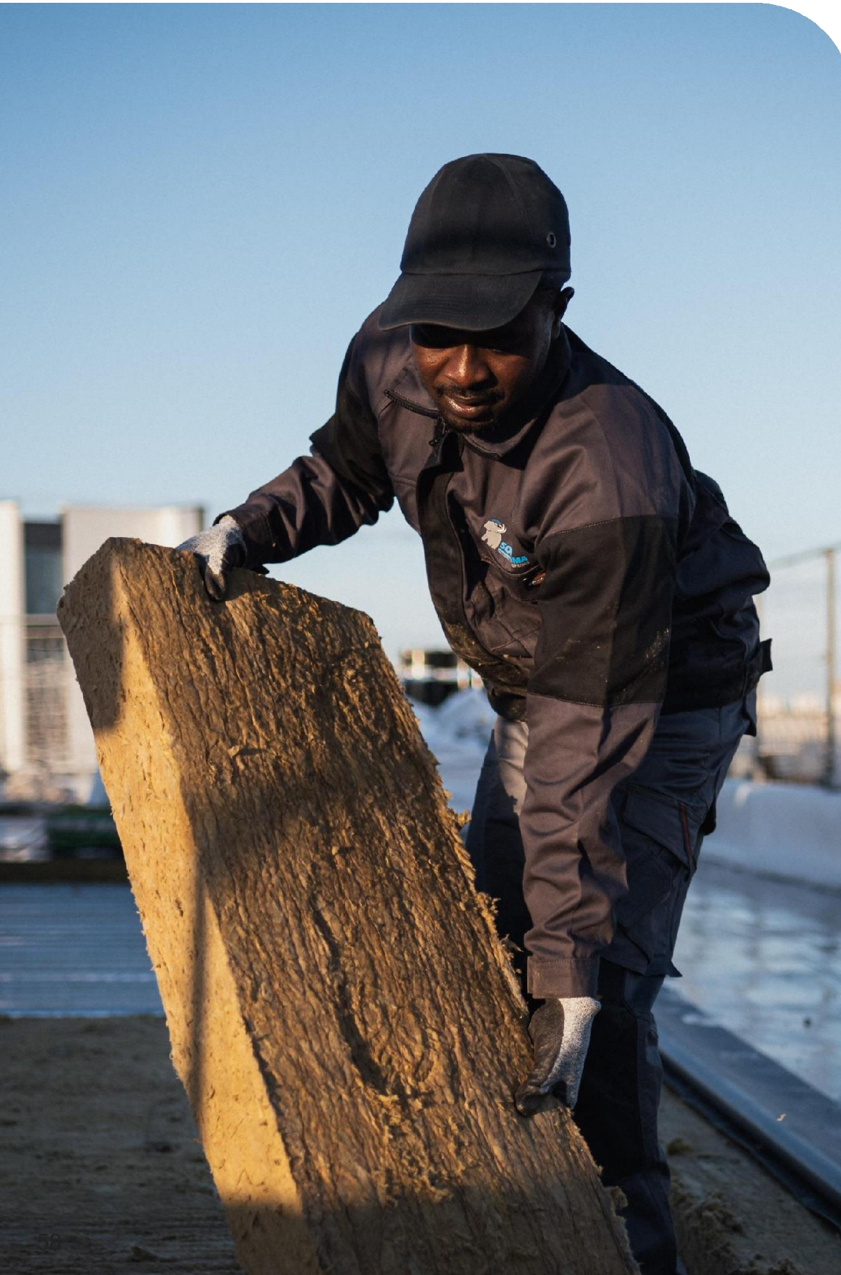
Chantier SIEDS Poitiers - Crédit photo : ATYPIX - SOPREMA Entreprises
